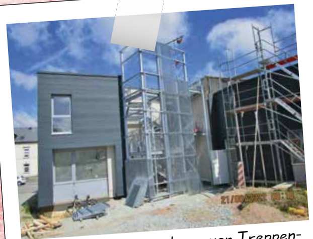
Die Hauptfunktion des neuen Treppen- und Übungsturms ist die Nutzung als Rettungsweg aus dem Gebäude, gleichzeitig dient er der Feuerwehr zu Trainingszwecken (z.B. Anleiten).
