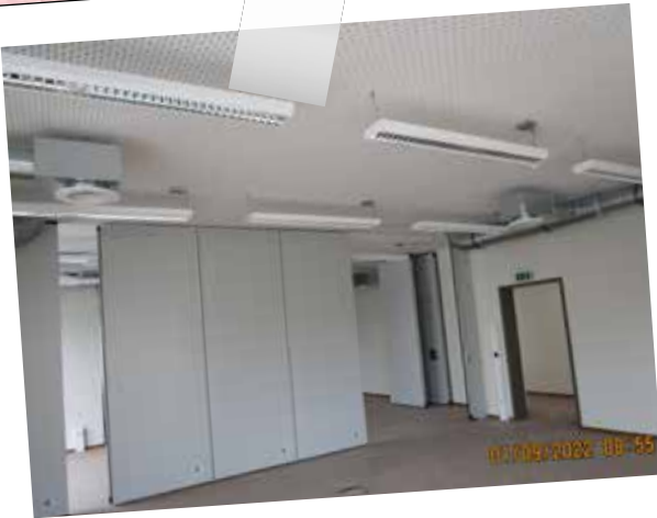
Hier entsteht der Schulungsraum mit mobiler Trennwand.
