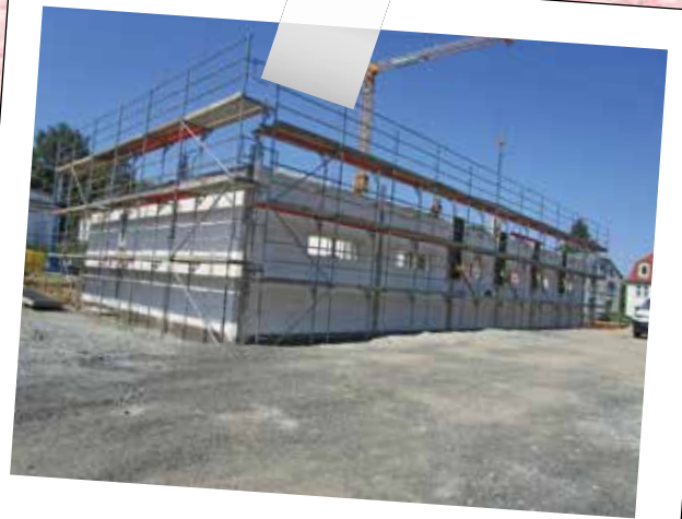
Die Fahrzeughalle nimmt langsam Gestalt an.
