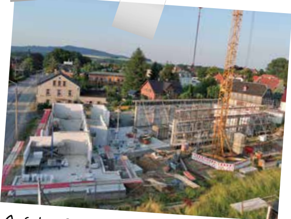
Auf der Gesamtaufnahme der Baustelle „neues Gerätehaus“ wird ersichtlich, wie wichtig eine ordentliche Koordination ist, damit der Bauablauf gewährleistet wird.
