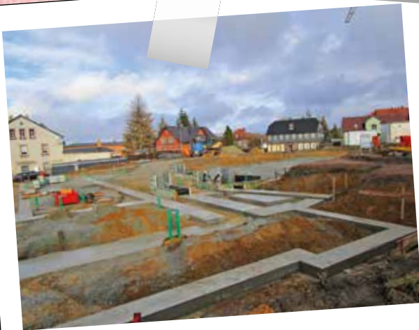
fertiggestellte Fundamente und Grundleitungen
